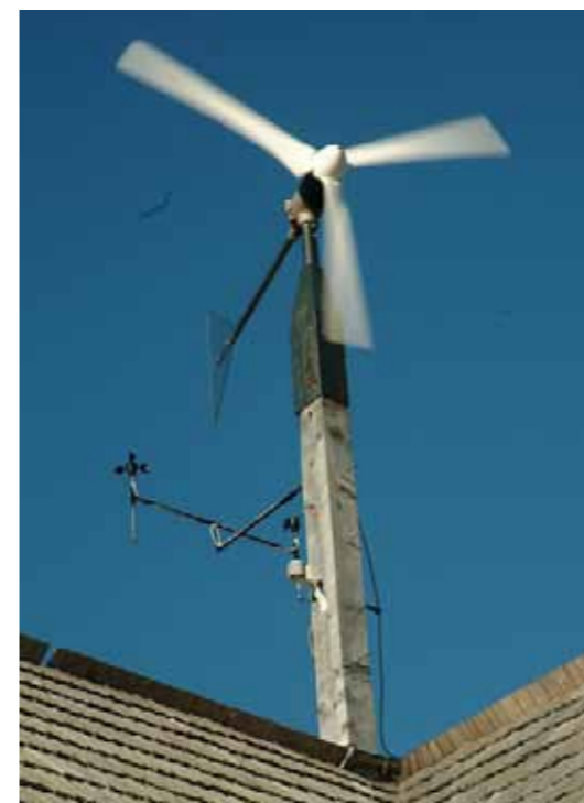
Az Ökoház tetején jelenleg három szélkerék működik, melyek az épület elektromosenergia-igényének csaknem 50 százalékát biztosítják.
